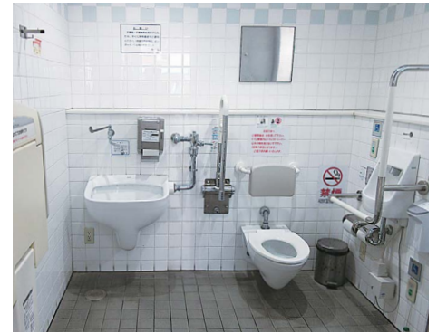
洗浄装置なし便座、おむつ交換台、オストメイト用設備を備える多機能型で、車いすの転回可能な広さがあります。
