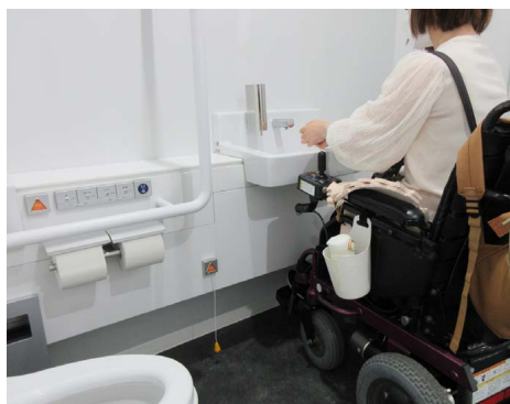
視覚障害者のためにスイッチの高さを揃えてあります。(市役所内の全てのバリアフリートイレ)
