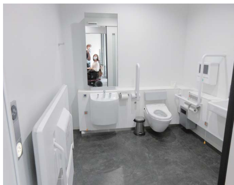
1階西側バリアフリートイレ 洗浄装置付き便座、ベビーチェア、多目的シート、チェンジングボード、オストメイト用設備を備える多機能型。車いすの転回可能な広さがあります。
