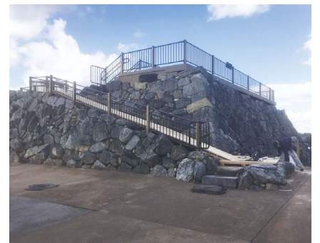
郡山城天守台 仮設スロープ制作の様子
