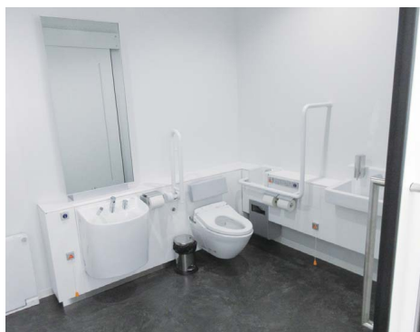
3階西側バリアフリートイレ 洗浄装置付き便座、チェンジングボード、オストメイト用設備を備える多機能型。車いすの転回可能な広さがあります。
